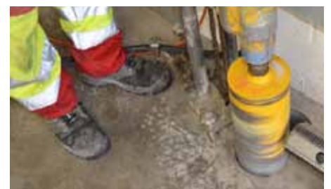
Die Bohrkronen frisst sich durch Drehbewegungen in den Beton. Weil es sich bei dieser Maschine um eine kleinere handelt, kann sie direkt an die Steckdose geschlossen werden.
