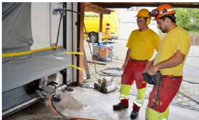
Die Steuerung der Fräsmaschine erfolgt per Fernbedienung.
