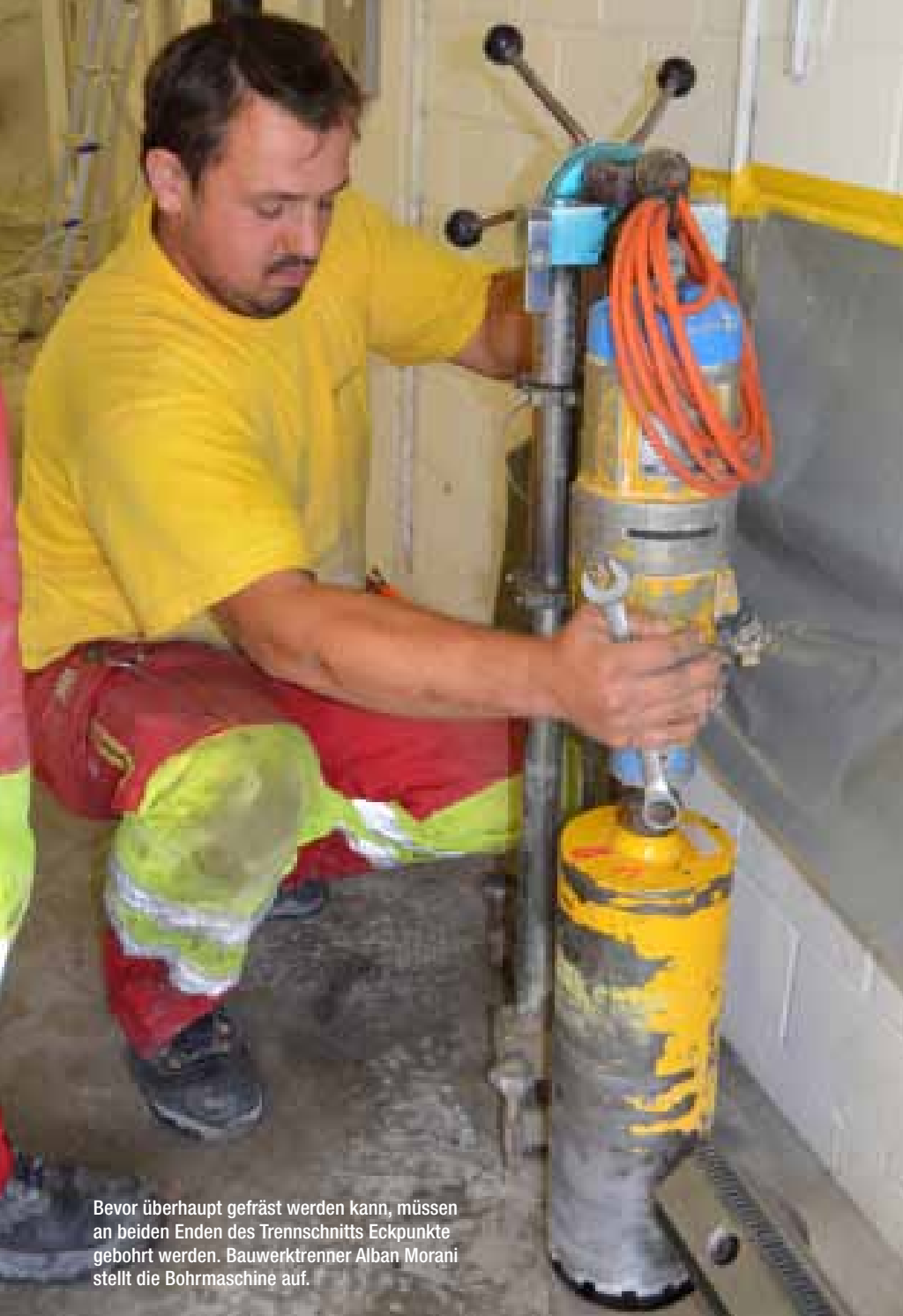
Die Bohrkronen frisst sich durch Drehbewegungen in den Beton. Weil es sich bei dieser Maschine um eine kleinere handelt, kann sie direkt an die Steckdose geschlossen werden.
